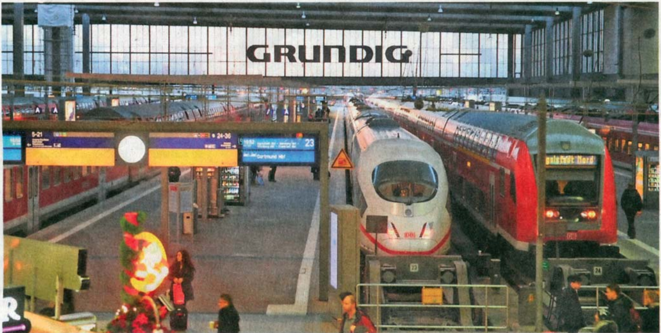
Die alten Lampen waren weit oben montiert, sie konnten den Bahnsteig nicht richtig ausleuchten.
